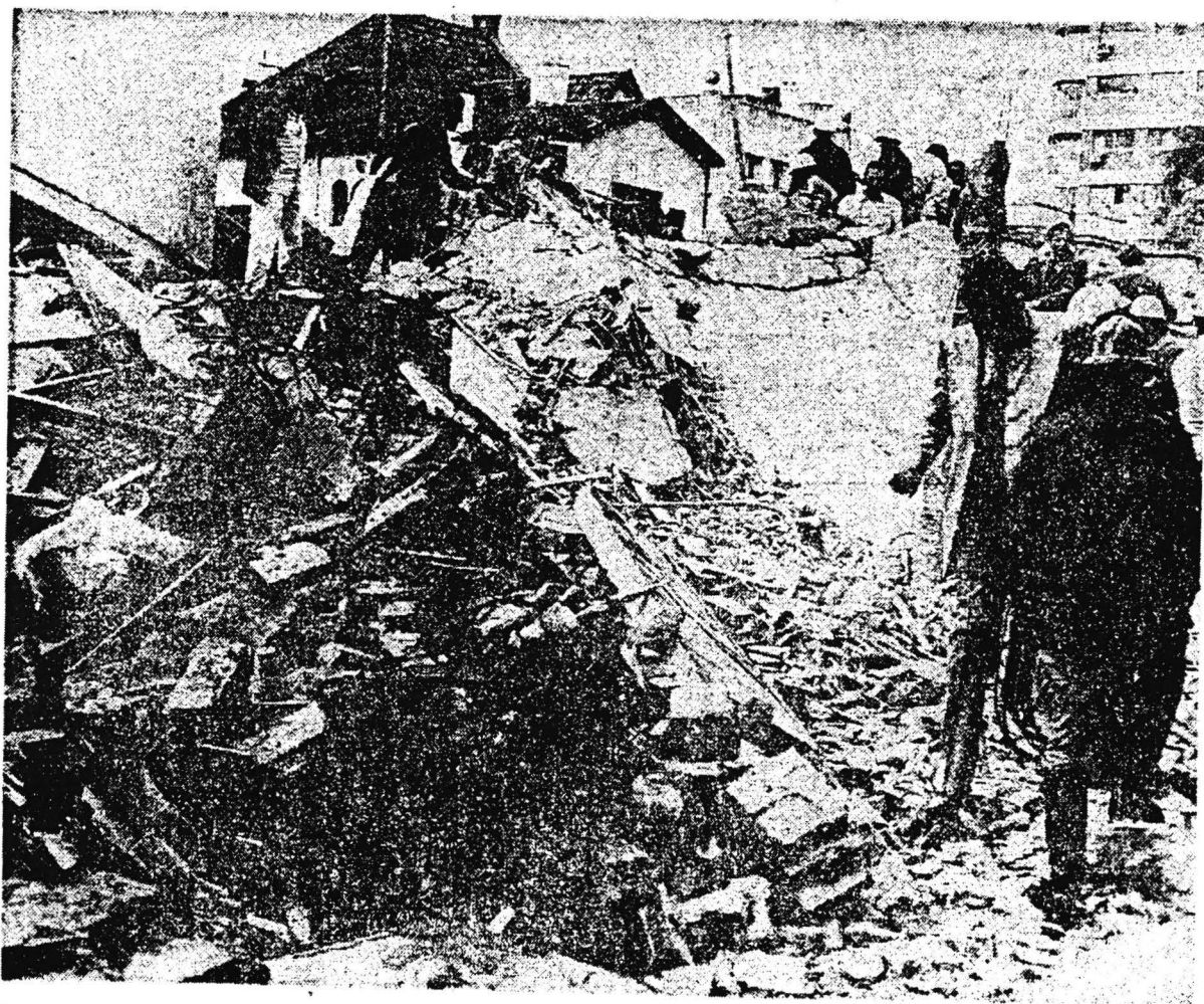
Peritos policiales, bomberos y personal municipal inspeccionan los escombros de la residencia de G. Klein
