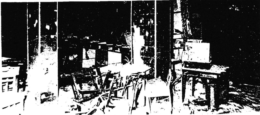
UN ASPECT des dégâts produits par la bombe placée par un terroriste d'extrême gauche dans la salle à manger d'un organisme de la Police, la Superintendencia de Seguridad Federal, au moment où des centaines de personnes y déjeunaient.
